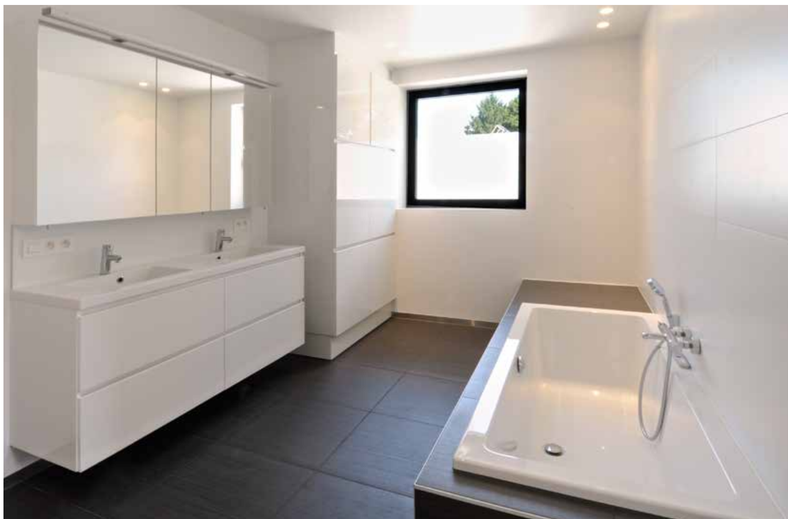
Firma Beyst installeerde het sanitair & de verwarming.
